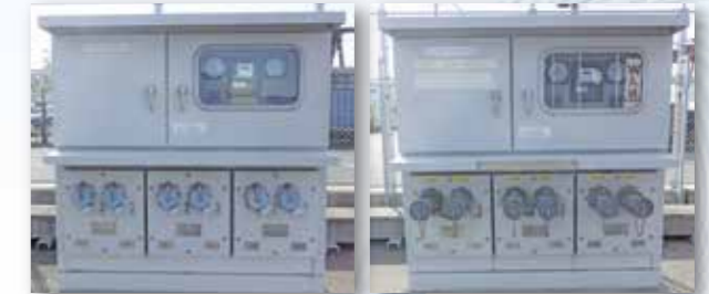
H7.H15年設置 Installed in 1995 and 2003
